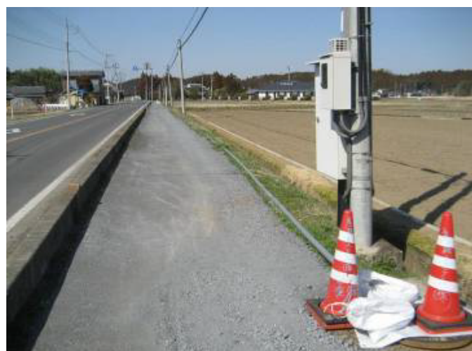
仮配管による応急状況(水戸市上国井地区)
