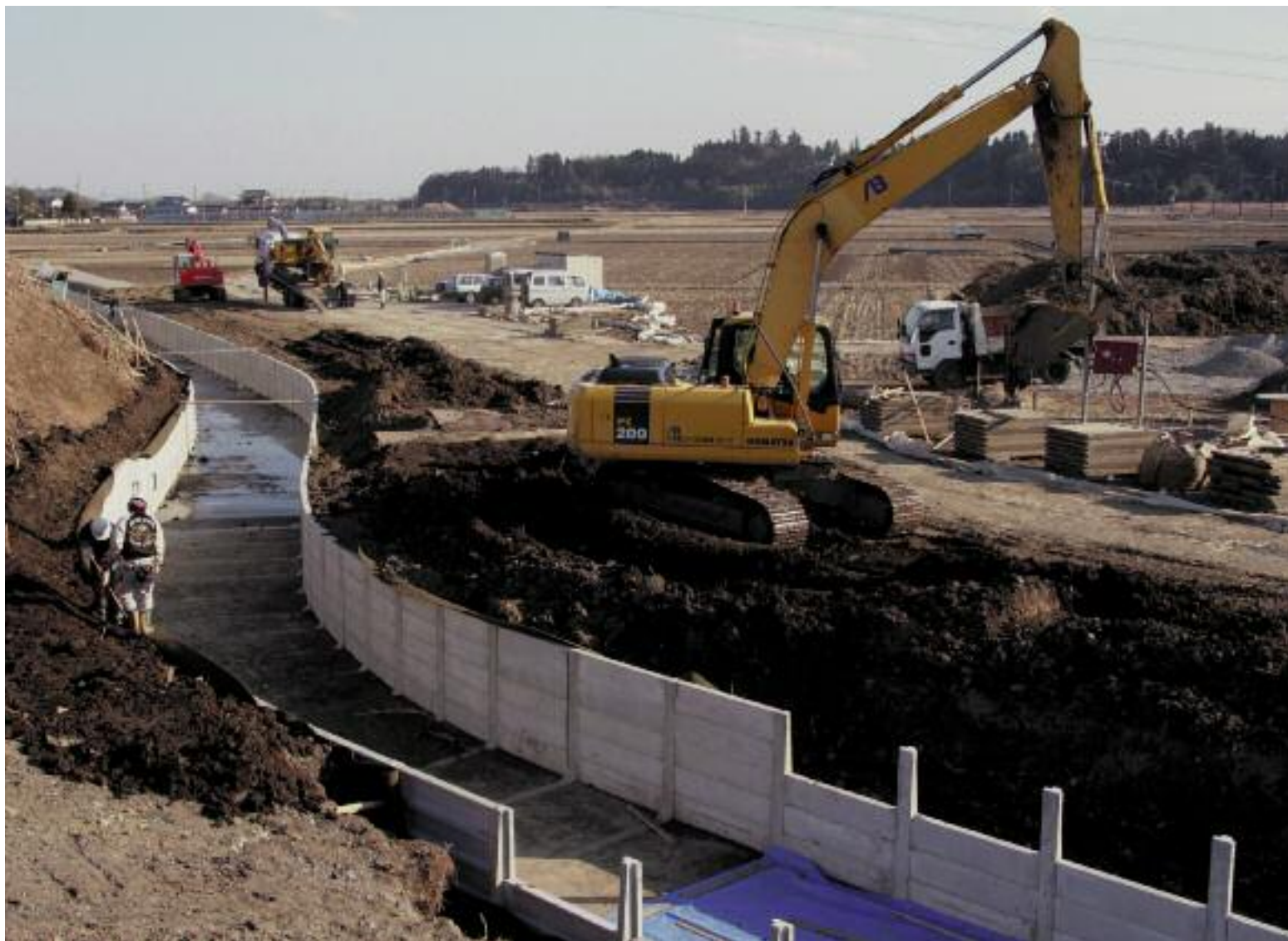
「水路完成間近」 撮影場所／常陸大宮市 大高 壽
