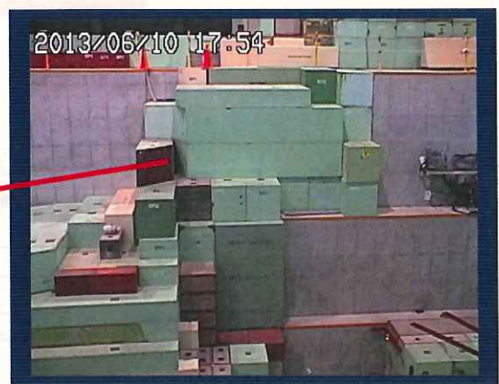
遮蔽壁の外観
