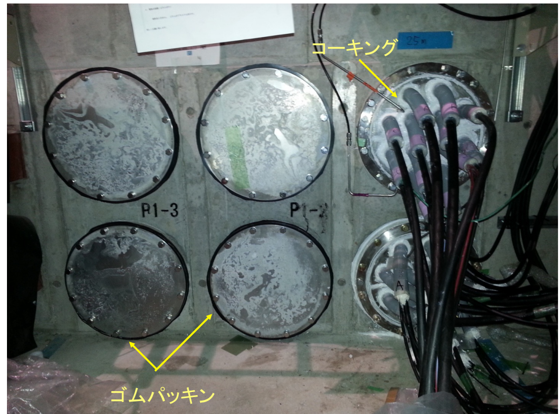
P1[実験エリア側施工後写真]
