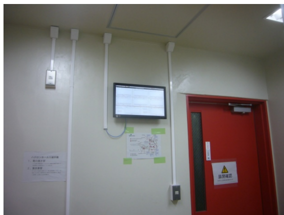
ホール北側入口
