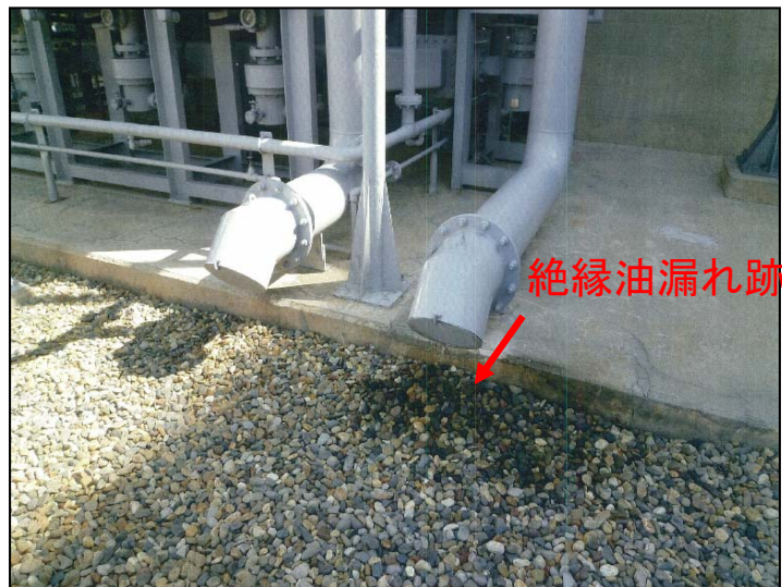
起動変圧器2A
