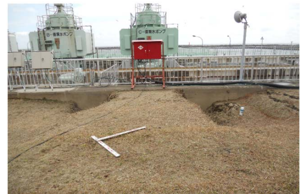
写真②(循環水配管埋設エリア)
