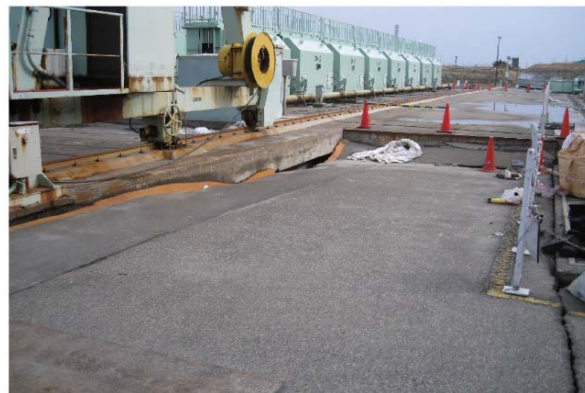
写真④(取水口エリア)
