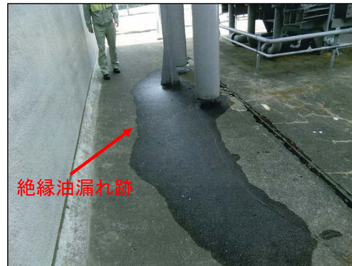
起動変圧器2B
