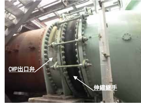
図6.16 循環水ポンプ出口管及び伸縮継手
