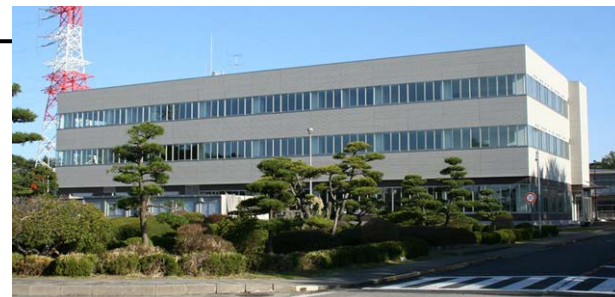
緊急時対策所
