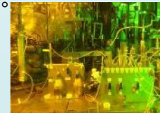
【セル内に設置された抽出クロマト試験装置】
