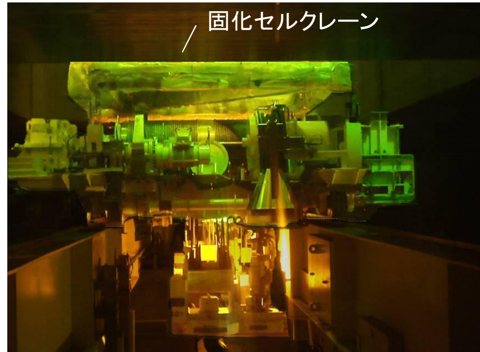
固化セルクレーン
