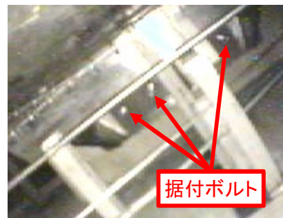
③ 据付ボルトの観察 (予備貯槽)
