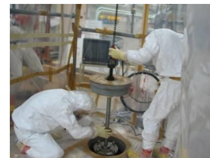
高線量下でのポンプ点検
