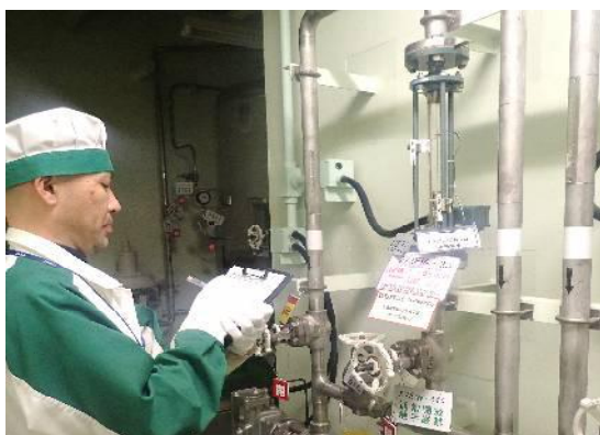
② 日常点検(エア流量の確認)
