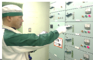
① 日常点検(機器の電流値確認)
