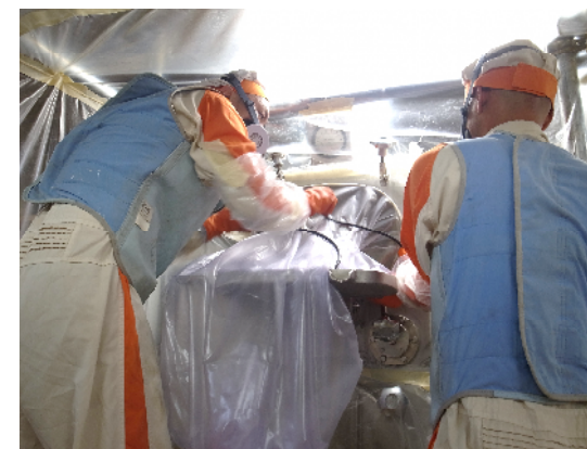
⑤ 点検保守(フィルタ交換)
