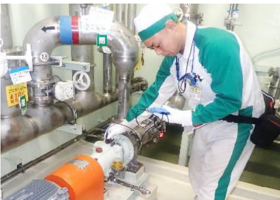
③ 月例点検(冷却水ポンプ)
