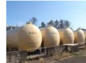
液体処理場(廃液タンク)
