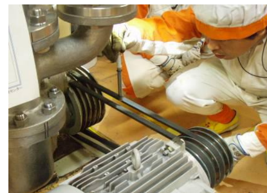
④ 点検保守(排風機のベルト交換)
