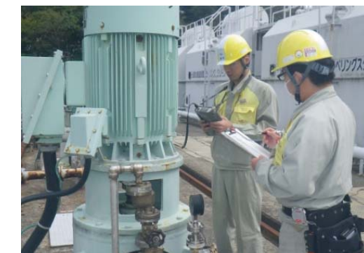
【直営での回転機振動測定】
