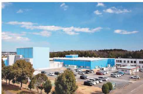
日本照射サービス(株)東海センターの外観
