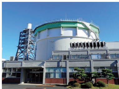
研究炉JRR-3の外観
