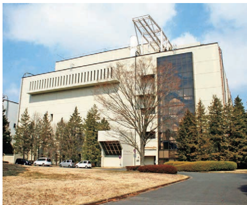
JT-60実験棟の外観
