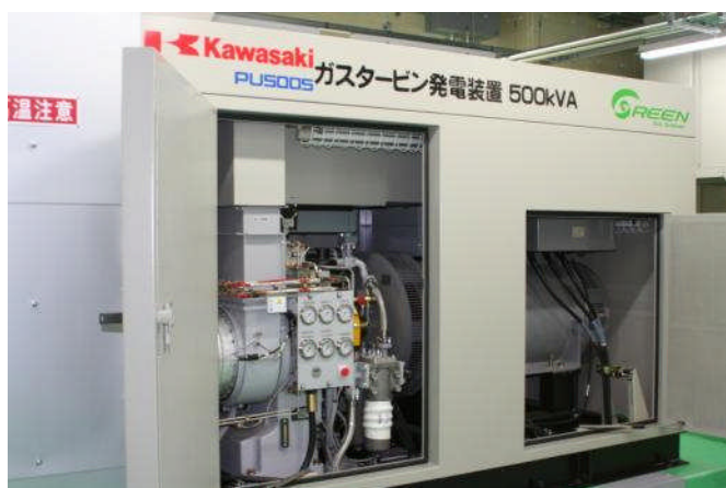
非常用発電機
