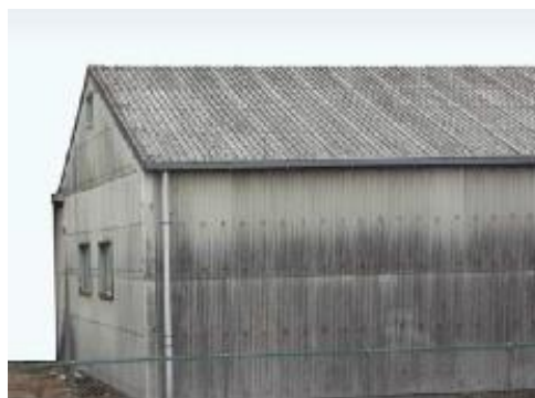
石綿含有スレート波板（屋根・外壁）
