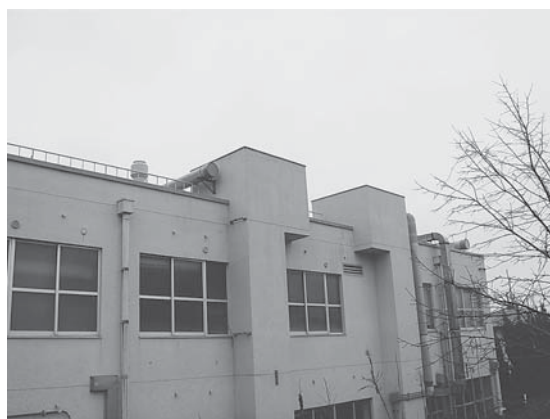
図4 旧センター外観2
