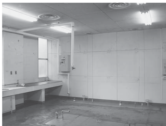
図6 RI 実験室ドラフト（撤去後）
