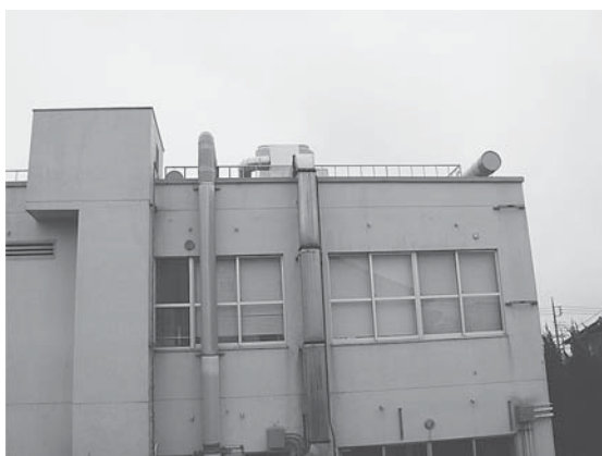
図3 旧センター外観1
