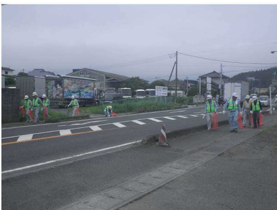
北茨城大子線での作業状況（北茨城市）
