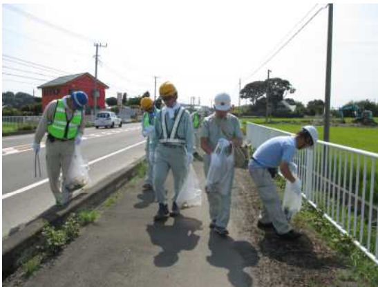
国道293号での作業状況（日立市）
