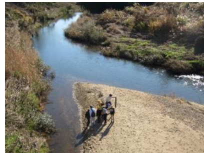
大古山橋（上流）
