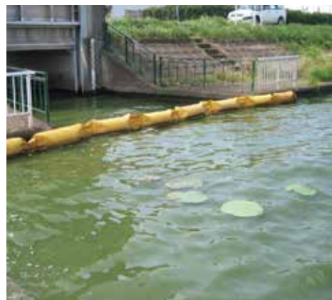
フェンスの設置
