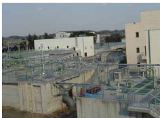
霞ヶ浦湖北流域下水道霞ヶ浦浄化センター
