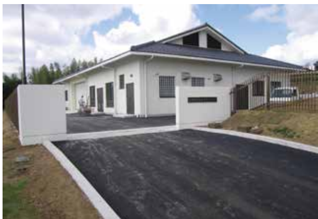
行方市玉造北部地区浄化センター（外観）
