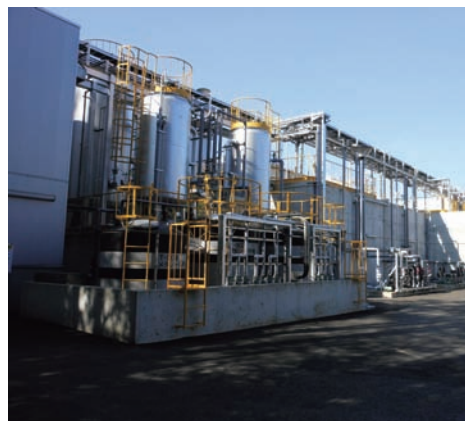
排水処理施設
