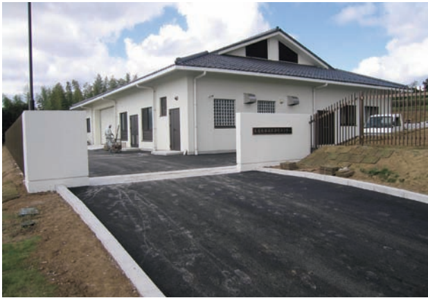
行方市玉造北部地域浄化センター（外観）
