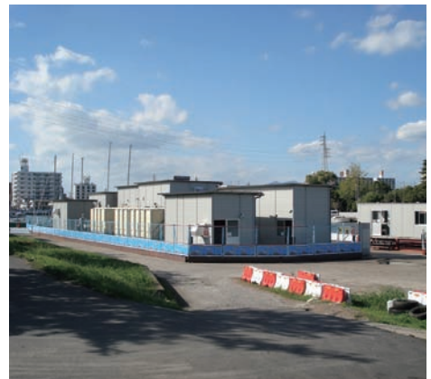
霞ヶ浦直接浄化実証施設
