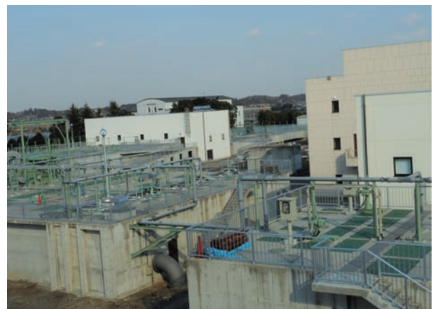
茨城県流域下水道事務所（外観）
