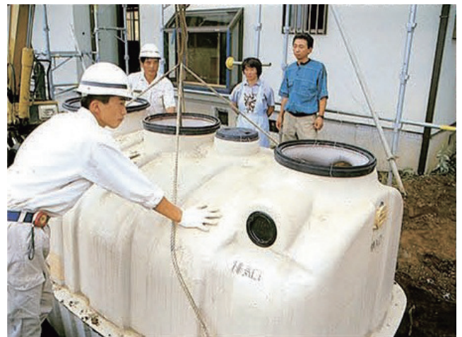
高度処理型浄化槽
