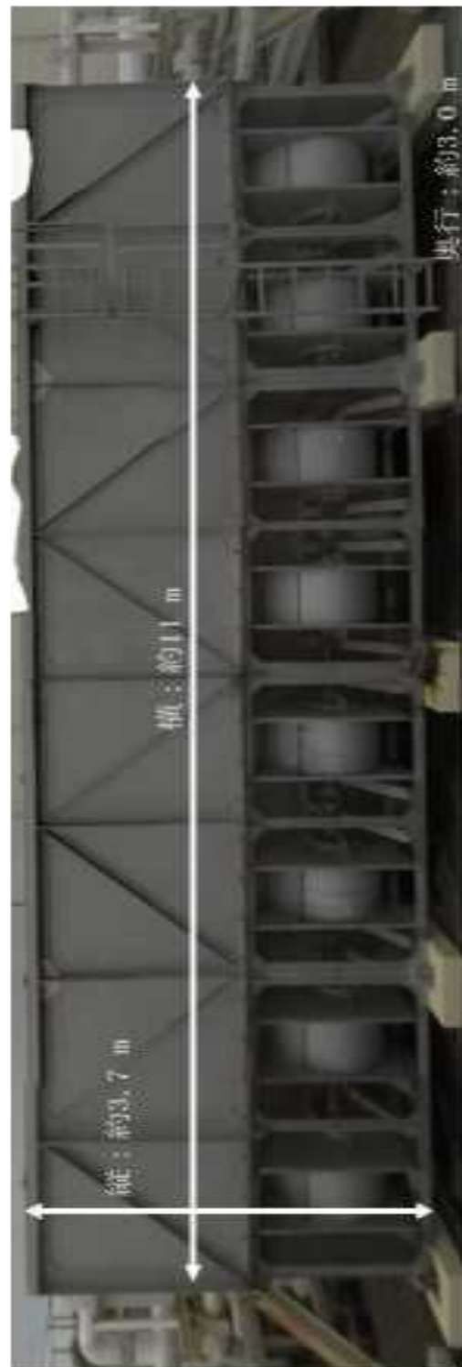
図 2 (1/2) 冷却塔概要 (高放射性廃液貯蔵場 (HAW))
