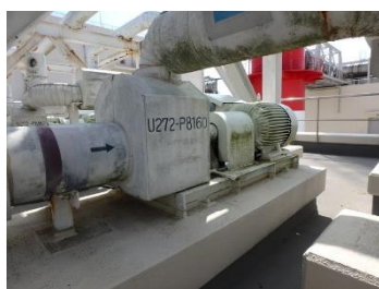
二次系の送水ポンプ
