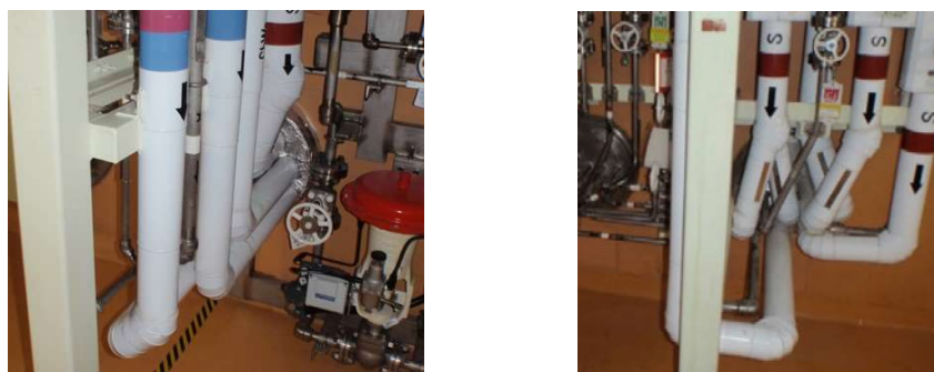
図-1 配管分岐室におけるセル貫通部の蒸気配管等の設置状況
