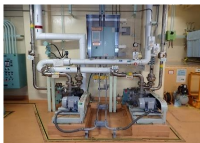
槽類換気系排風機
