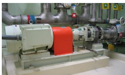
一次系の送水ポンプ
