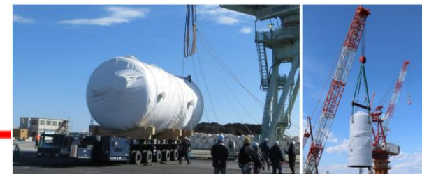
フィルタ付きベント装置 据付作業の様子
