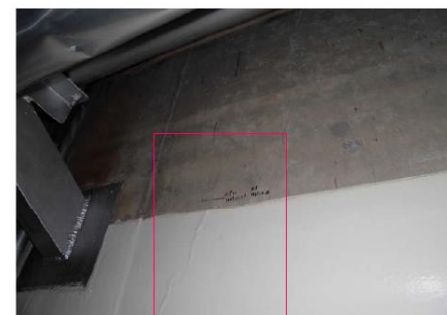
原子炉建屋5階壁面
