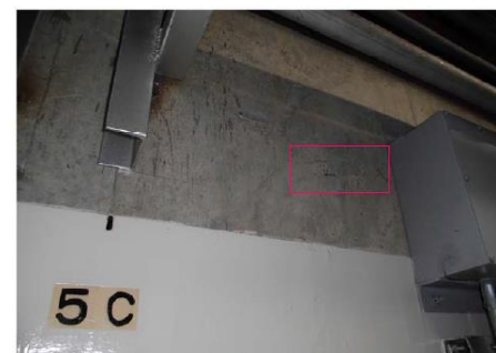
原子炉建屋3階壁面
