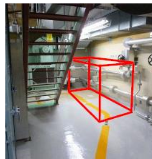
常設高圧代替注水系ポンプ
