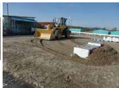
ホイールローダによるがれきの撤去の検証
