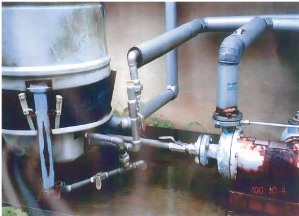
転換試験棟の外に設置されているクーリングタワーの配管 (臨界終息のため、当該配管から沈殿槽冷却水ジャケットの水抜きを実施)
