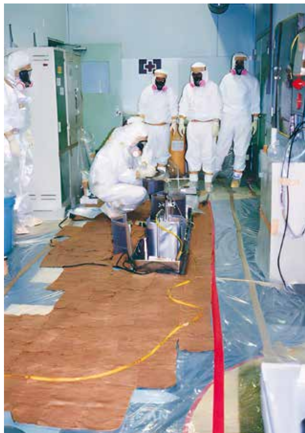
沈殿槽からの溶液抜き取り作業
