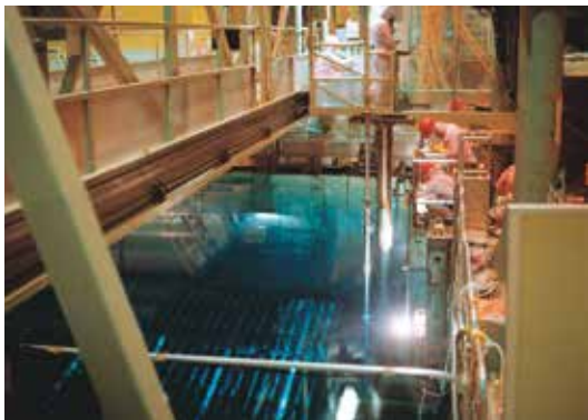
使用済燃料貯蔵プールでの燃料移動作業（原電）
