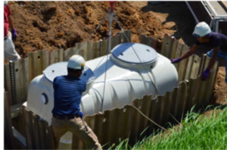
(高度処理型浄化槽の設置)
