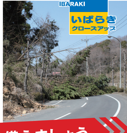
土砂崩れの様子(常陸大宮市)
