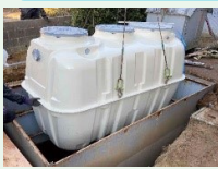
高度処理型浄化槽の設置
