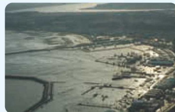
大洗港津波被害
