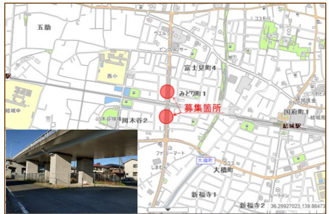
④川木谷橋 (県道結城野田線 結城市みどり町)
