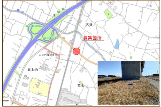
②正上内跨線橋 (県道 上吉影岩間線 石岡市石岡)
