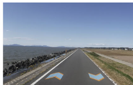
矢羽根の設置
