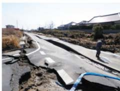
液状化による道路のうねり (鹿嶋市)
