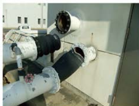
排水管の損傷 (那珂久慈浄化センター)
