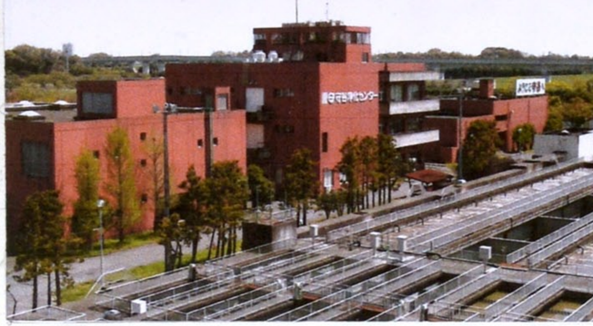
写真:守谷浄化センター(下水処理場)
