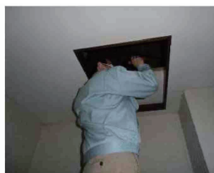
「小屋組・梁」調査
