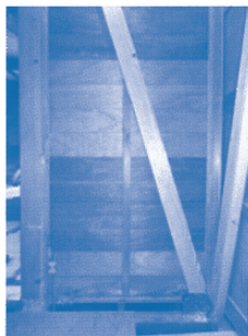
◀◀耐震改修事例 ・既存の壁に筋交いを入れて補強
