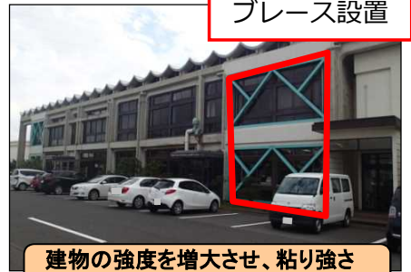
ブレース設置
