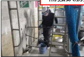
補強鉄筋挿入
