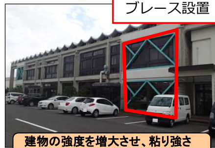
ブレース設置
