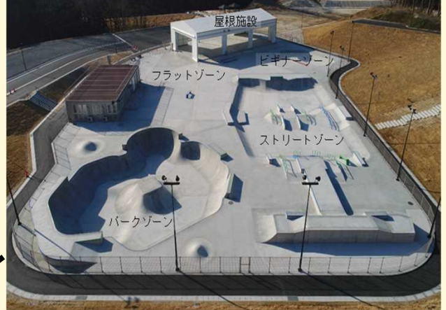
スケートボード施設全景
