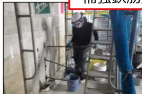
補強鉄筋挿入
