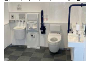
多目的トイレ改修
