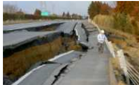
写真① 常磐自動車道 水戸IC～那珂IC（上り線） ⇒盛土崩落、路面の陥没、 波打ちにより通行不能
