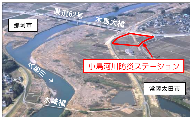
久慈川：小島河川防災ステーション
