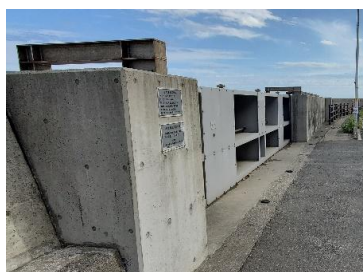
写真 3.10 水門・陸閘および乗り越しタイプ階段の整備例
