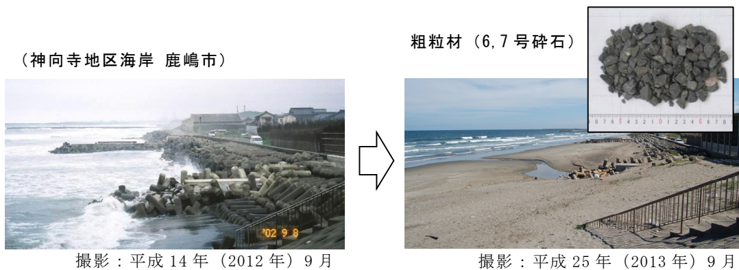
写真 3.5 粗粒材養浜の効果
