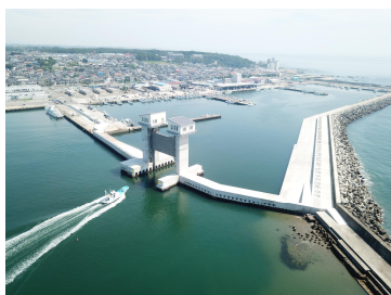
写真 3.10 水門・陸閘および乗り越しタイプ階段の整備例
