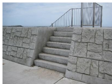
写真 3.10 水門・陸閘および乗り越しタイプ階段の整備例
