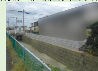
浸水防止塀の設置例（金沢川沿い）
