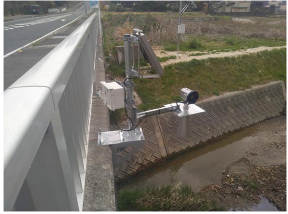
危機管理型水位計の設置イメージ
