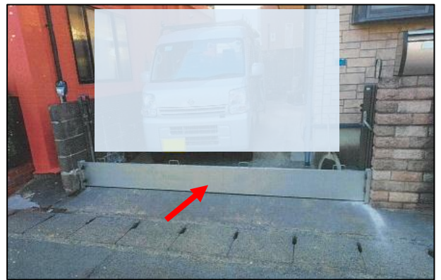
工事実施事例(日立市)
