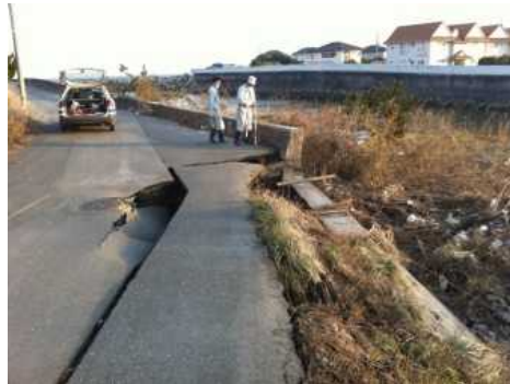
図 1-10 (3) 津波により被災した護岸
