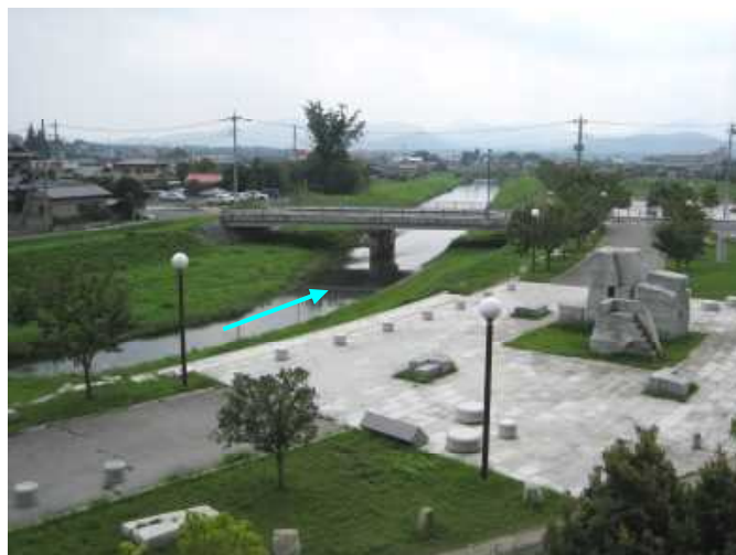
写真-1-5 ふるさとの川整備事業実施の状況
