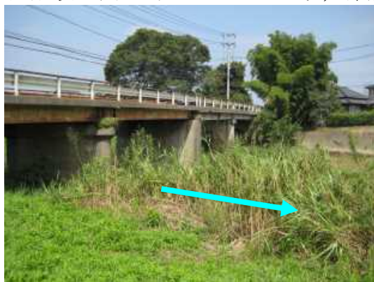
写真-2-1 宍戸橋の状況（澗沼川） ※流下能力不足の橋梁箇所
