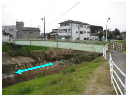
写真-2-2 長岡橋上流の状況（澗沼前川） ※人家連担区間
