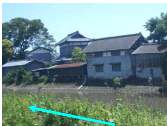
写真-2-3 石川川下流部の状況
