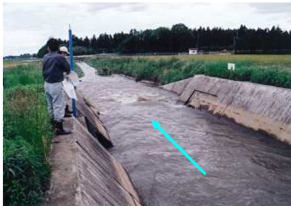
写真-2-5 洪水時の河川巡視点検の状況（涸沼前川）
