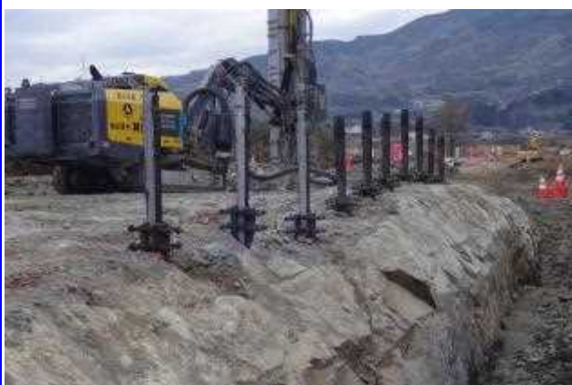
スーパーくさび君立て込み完了
