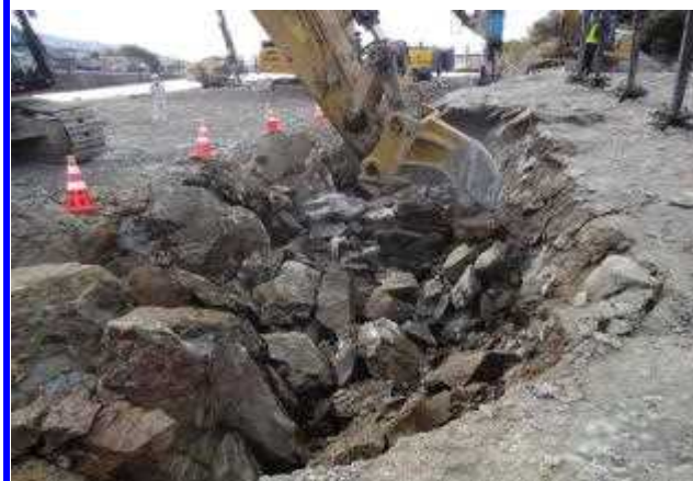
引き起し状況
