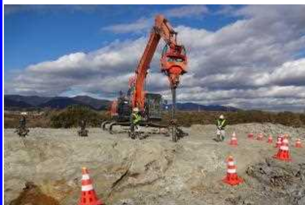
バイブロハンマーによる引抜
