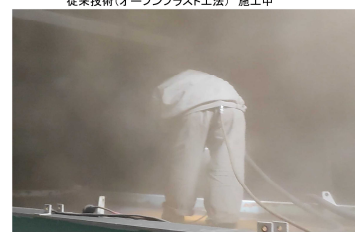
ブラスト施工時の粉じん発生状況比較
