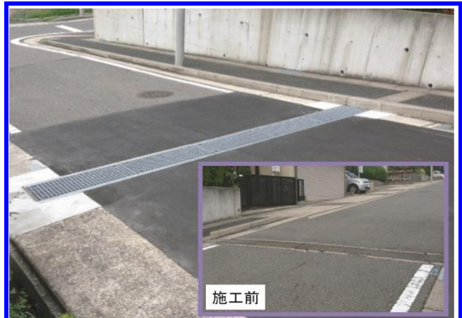
施工実績②
