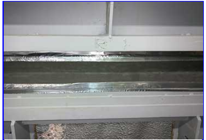
セントル外板の内面に取付た状況
