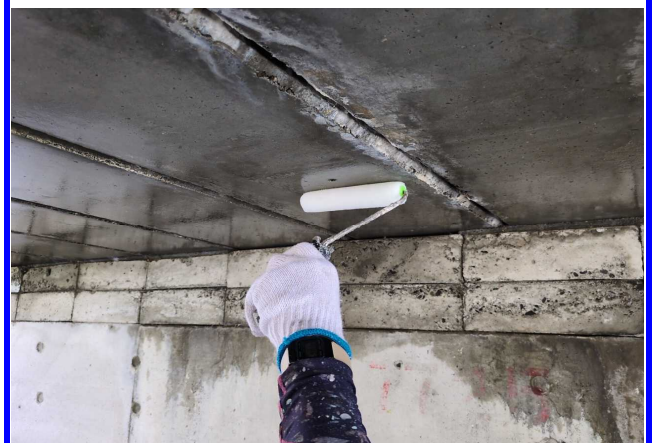
塗布状況 (ローラー)
