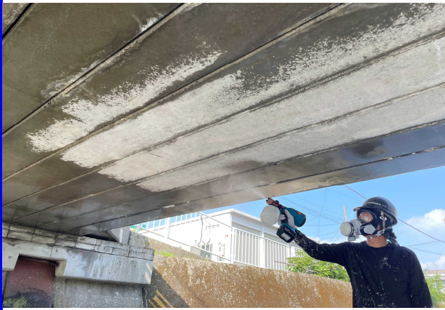
塗布状況 (噴霧器)
